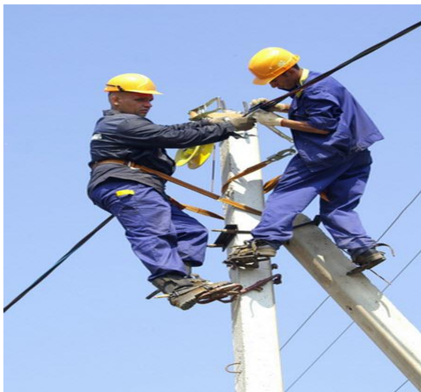
Рис.4. Монтаж линии СИП
